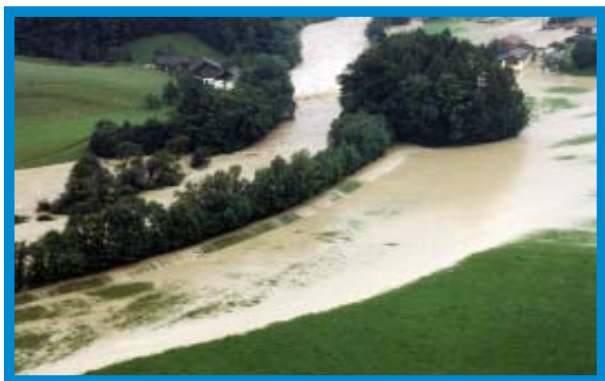
Überströmung eines Hochwasserschutzdammes an der Lammer bei Golling, August 2002
